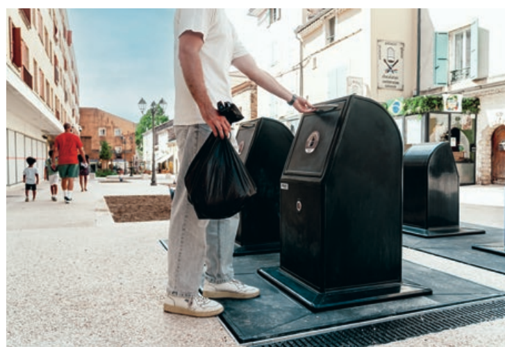
Déposés directement dans les trappes, les déchets prennent désormais le chemin du sous-sol. Un dispositif plus discret, intégré au réaménagement de la place.
