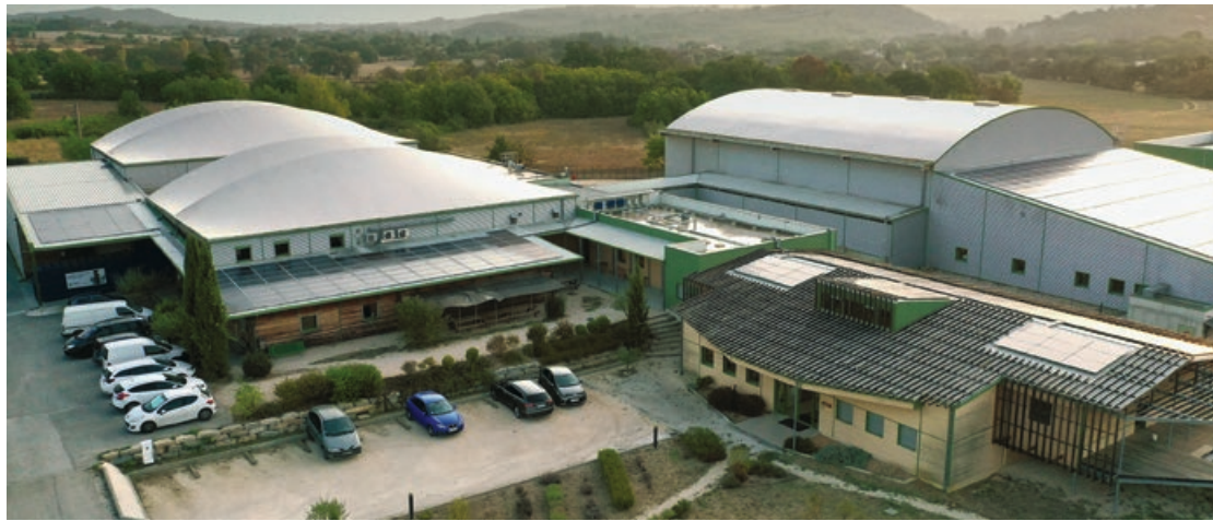
À Méjannes-lès-Alès, le site industriel d'Arcadie change d'échelle avec un nouveau bâtiment de 4 422 m 2 dédié à la production et au stockage.
