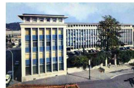
La cité administrative construite en 1966 sur l'emplacement de l'hôpital, place des Martyrs. Détruite en 2014.
