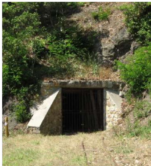
Porte d'accès aux mines pour les chiroptères
