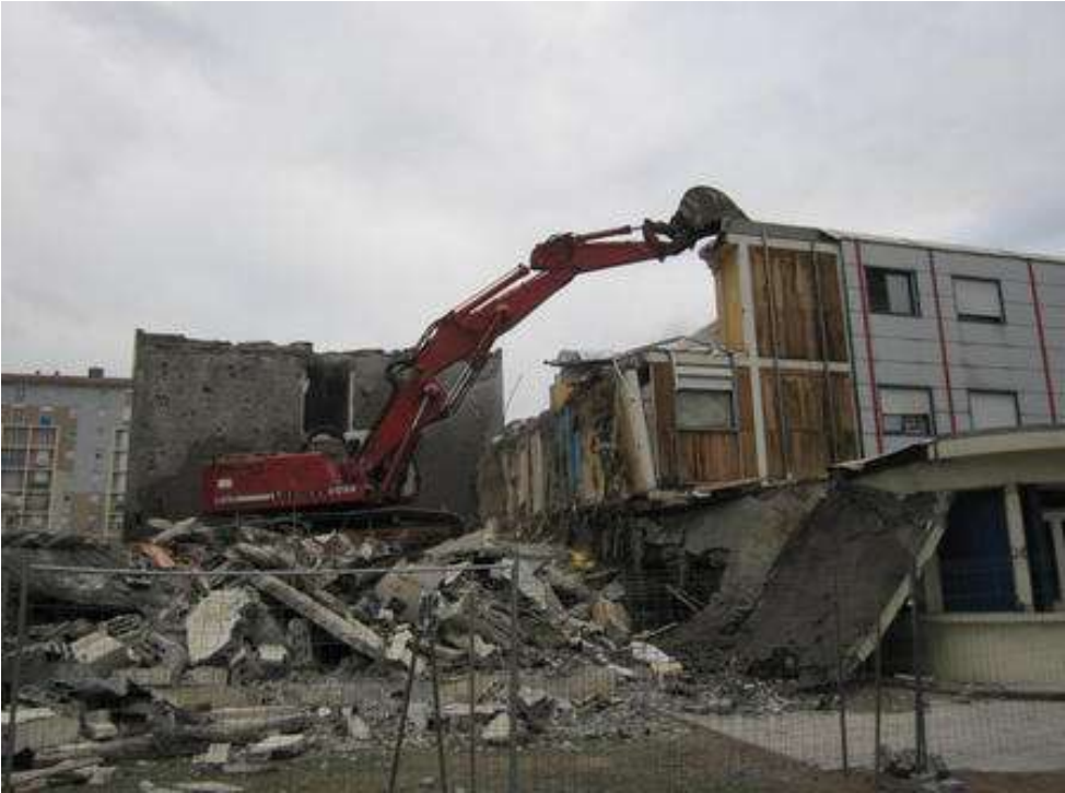
Exemple de rénovation lourde // Photo de chantier
