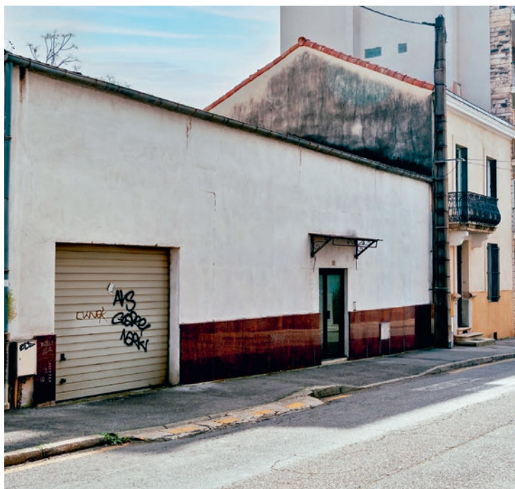
Le bâti existant au n°11 du boulevard Anatole France sera démolit avant la construction d'un immeuble de quatre étages.
