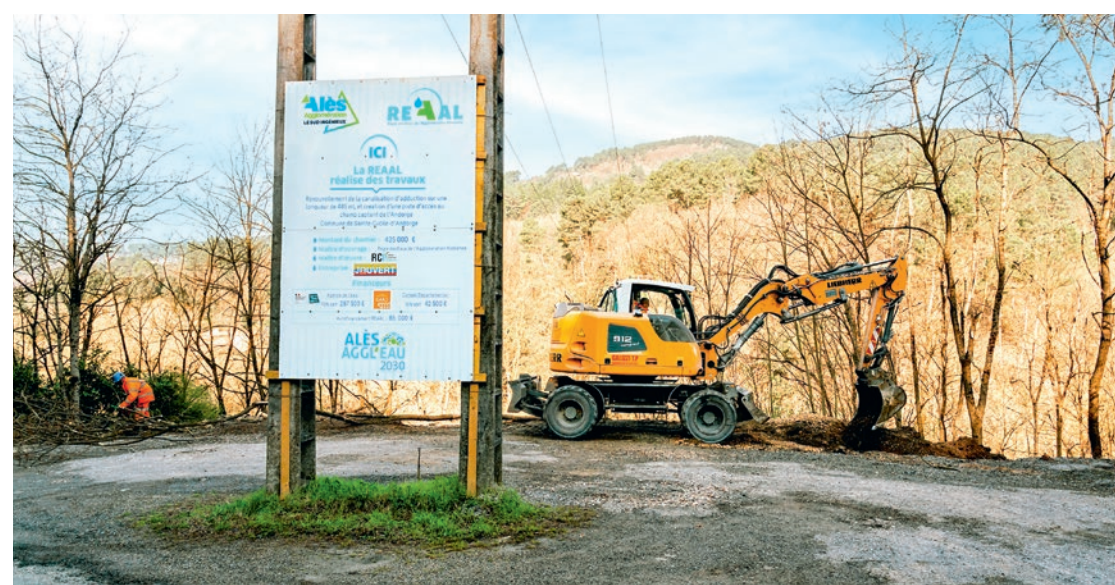
Des travaux forestiers sont nécessaires pour créer la piste permettant d'accéder au captage.
