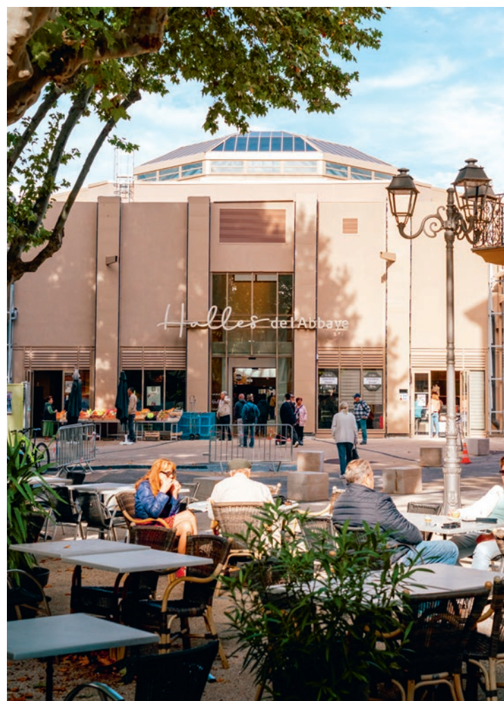
Le premier étage des Halles de l'Abbaye d'Alès sera aménagé dans le cadre des premières opérations de la foncière portée par la SAEM'Alès.
