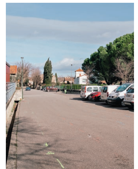
Situé au sud de Cruviers-Lascours, le premier secteur en travaux débute aux abords du stade de football.
