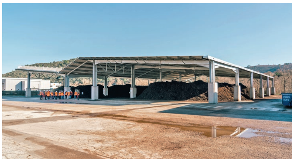
Désormais entièrement recouverte, la plateforme de compostage des Salles-du-Gardon a diminué de près de 60 % ses rejets dans le réseau d'assainissement.
