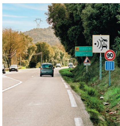
Pendant toute la durée du chantier, la voie de dépassement sera condamnée sur la RN 106.
