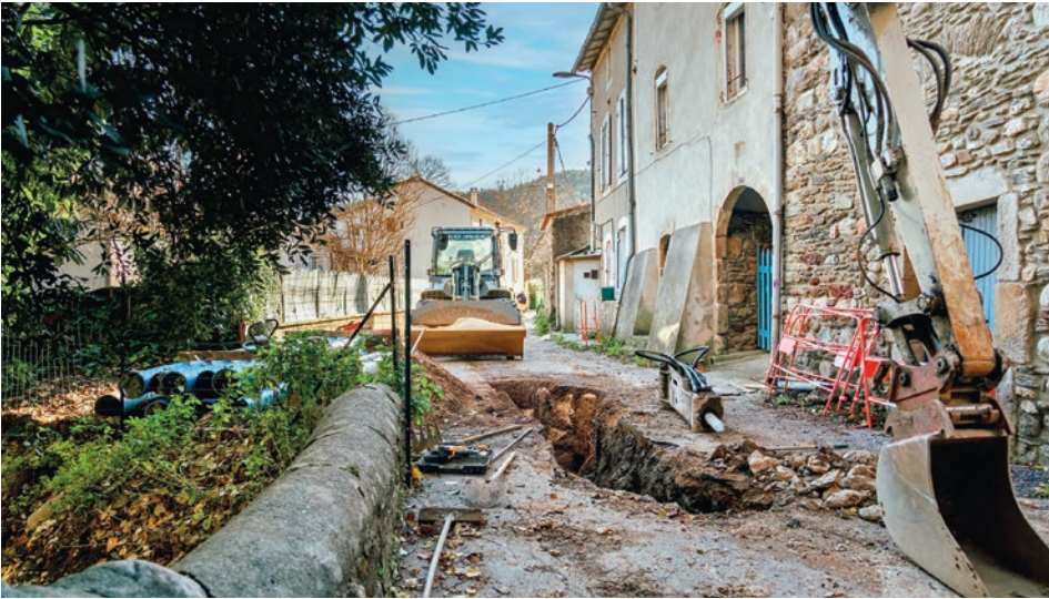
Dans la rue du Vallon et dans la rue de la Cantonade, 762 mètres de conduite d’eau potable sont actuellement en cours de remplacement.
