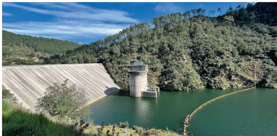
Du haut de ses 42 m, le barrage de Sainte-Cécile-d'Andorge pourrait retrouver sa capacité de stockage initiale grâce à l'extraction de 800 000 m 3 de sédiments ou une éventuelle rehausse.
