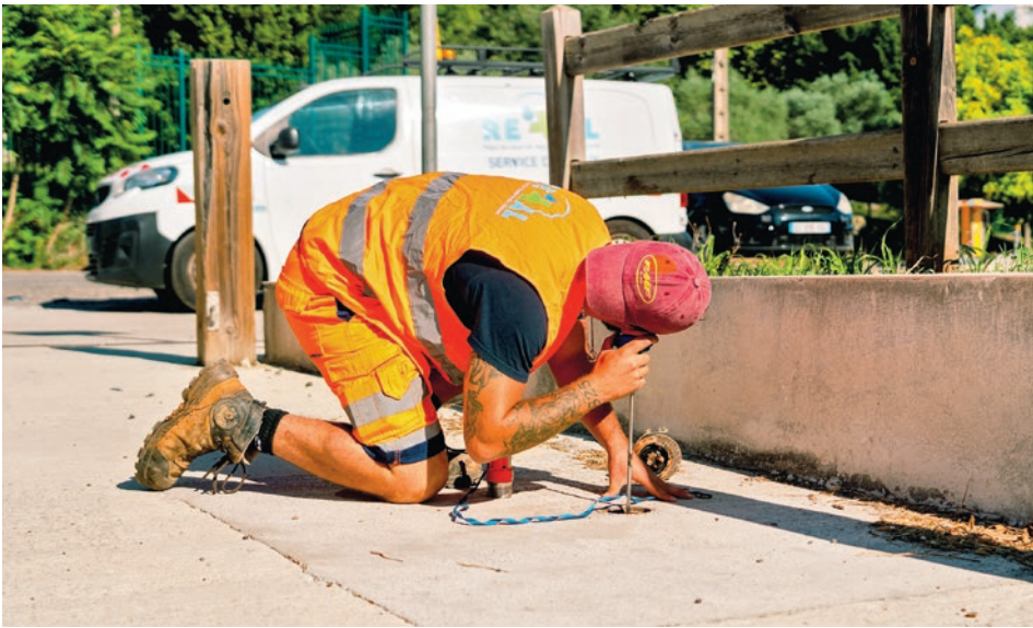
Les agents spécialisés de la REAAL utilisent des instruments spéciaux et toutes leurs connaissances des 2 000 km du réseau pour traquer les fuites d'eau dans les 71 communes d'Alès Agglomération.
