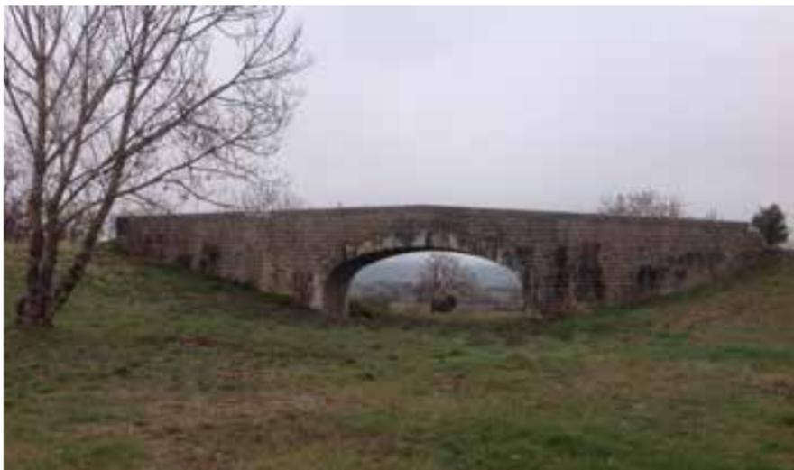
Ce Pont situé en rase campagne permettait le passage de la transhumance. C'était un chemin de muletiers qui permettait d'enjamber la voie ferrée pour le passage des animaux. L'ouvrage d'art emblématique des Plans appelé « La Passerelle » a été construit aux alentours de 1880 par la compagnie ferroviaire Alais-Rhône-Méditerranée (ARM) lors de la création de la ligne reliant le port de l'Ardoise pour le transport des minerais et combustibles cévenols.
