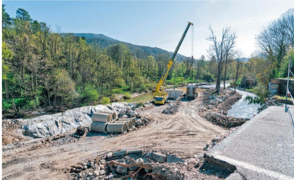
Mi-avril, les 9 blocs de béton de 14 tonnes chacun ont été livrés dans le lit du Luech. Ils forment le pont provisoire reliant Génolhac à Chamborigaud.
