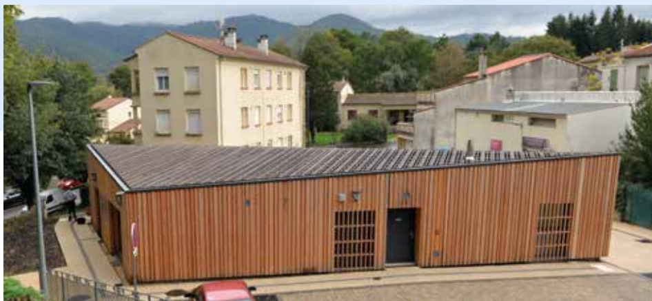
Le pôle Santé de Cendras a été fabriqué avec le pin maritime communal et travaillé en circuit court par la scierie Nogaret.
