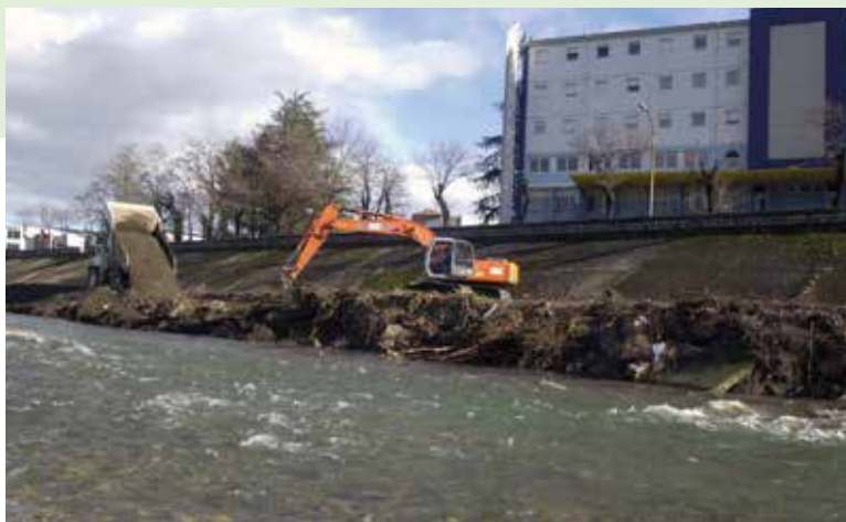
Déblaiement pour les travaux de sécurisation des berges du Gardon d'Alès.
