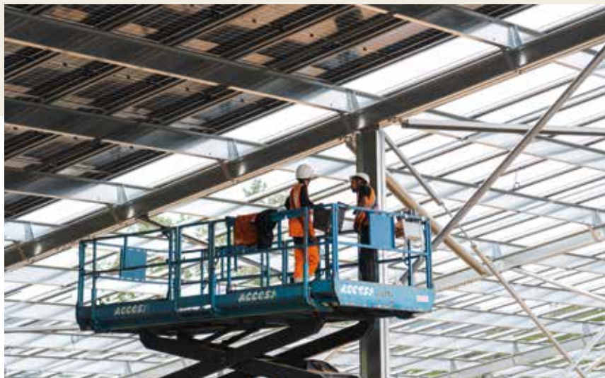
Installation des panneaux photovoltaïques sur le chantier de la centrale de Saint-Martin à Lavabreille.
