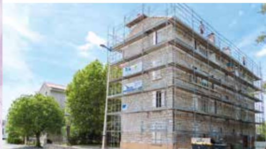
Parmi tous les travaux d'entretien du patrimoine de Logis Cévenols, la résidence Alsace, à Alès, a été rénovée en 2023.
