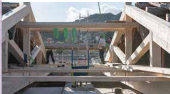
2 fermes de charpente ont pu être restaurées et 4 fermes de 22 mètres et 5 tonnes ont été entièrement remplacées, nécessitant de faire appel à des artisans du bois suisses et français.
