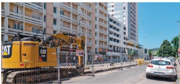
Le réseau chaleur de la Grand'rue Jean Moulin est en cours de rénovation. Le chantier devra être terminé au mois de novembre avant le lancement de la période de chauffe. Ce chantier permet de poser un réseau neuf et mieux isolé avant d'entamer les futurs travaux d'aménagement de la rue.
