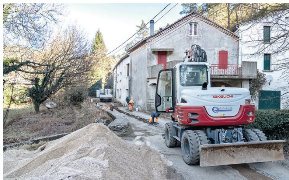
Ces nouvelles canalisations vont apporter un véritable confort aux habitants du secteur.
