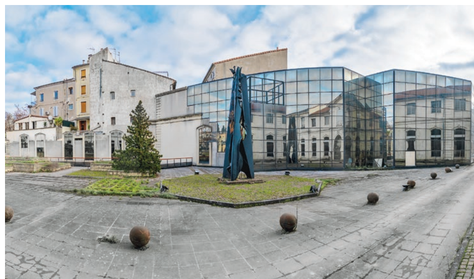
L'hôtel de police d'Alès sera situé dans les anciens locaux d'EDF, derrière l'ancien palais épiscopal.
