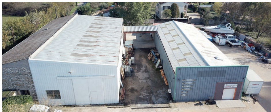
La toiture de l'atelier municipal de Mons est l'un des trois sites choisis pour produire de l'énergie solaire.
