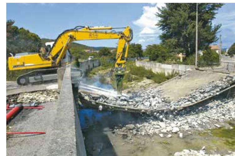
Pont du Grabieus à Saint-Martin-de-Valgalgues.
