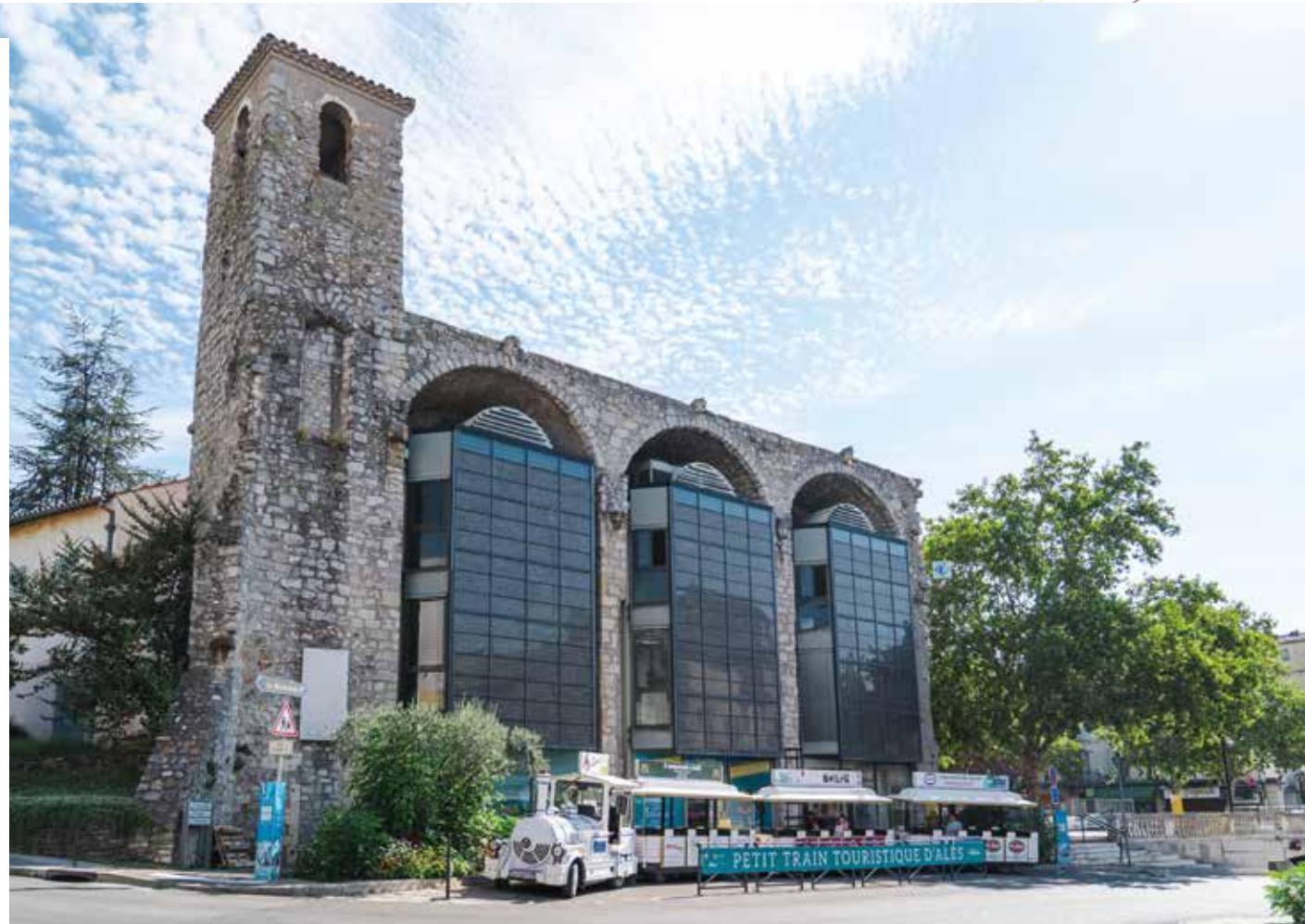
L'Office de Tourisme d'Alès a su être précurseur en matière de responsabilité environnementale avec ses 100 m 2 de panneaux photovoltaïques installés en 2003.
