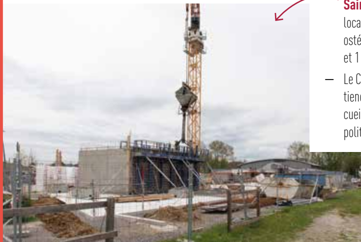
Une maison de santé pluri-disciplinaire à Saint-Julien-les-Rosiers.
