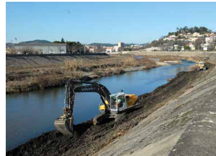
Déblaiement pour les travaux de sécurisation des berges du Gardon.
