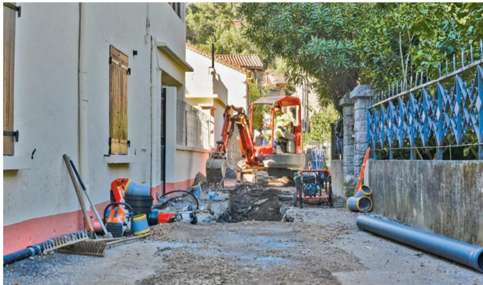
En plus du remplacement des canalisations d'eau potable, les travaux ont pour objectif de dédoubler le réseau d'assainissement afin de séparer les eaux de pluie.
