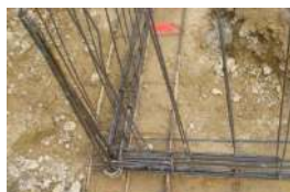
Nœud de chaînage - Continuité mécanique
