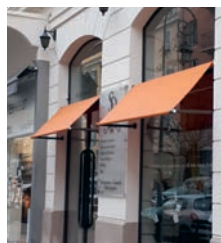
Dans l'embrasure sur une devanture rapportée ou sur une devanture en feuillure
