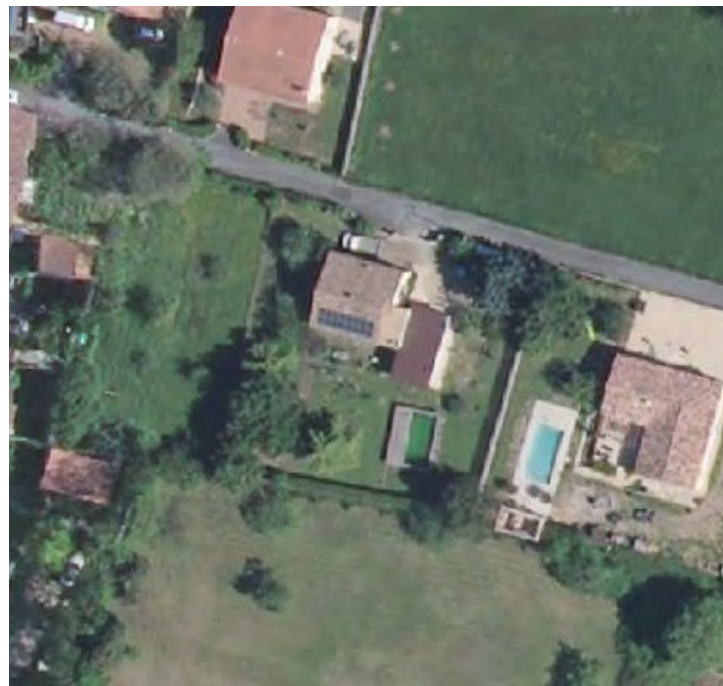
Une toiture d'une maison individuelle avec 23 m 2 de panneaux photovoltaïques.
