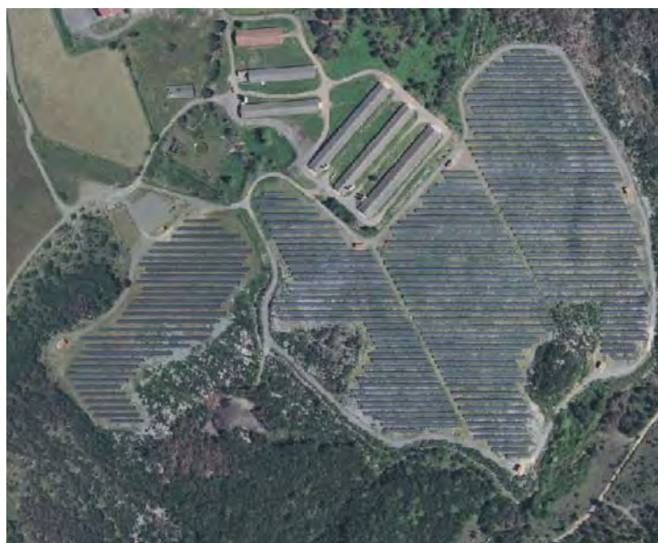
La ferme photovoltaïque de Plos à Saint-Jean du Pin fournit l'énergie électrique annuelle pour 1 700 foyers.
