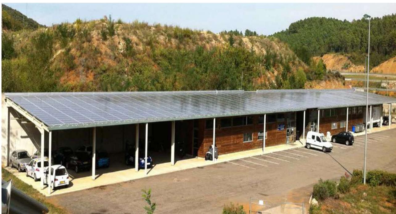
*Panneaux photovoltaïques intégrés en toiture des bâtiments du Pôle Mécanique*
