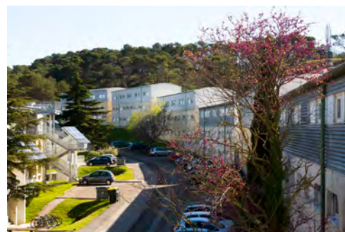
La Maison des Elèves de l'IMT Mines d'Alès
