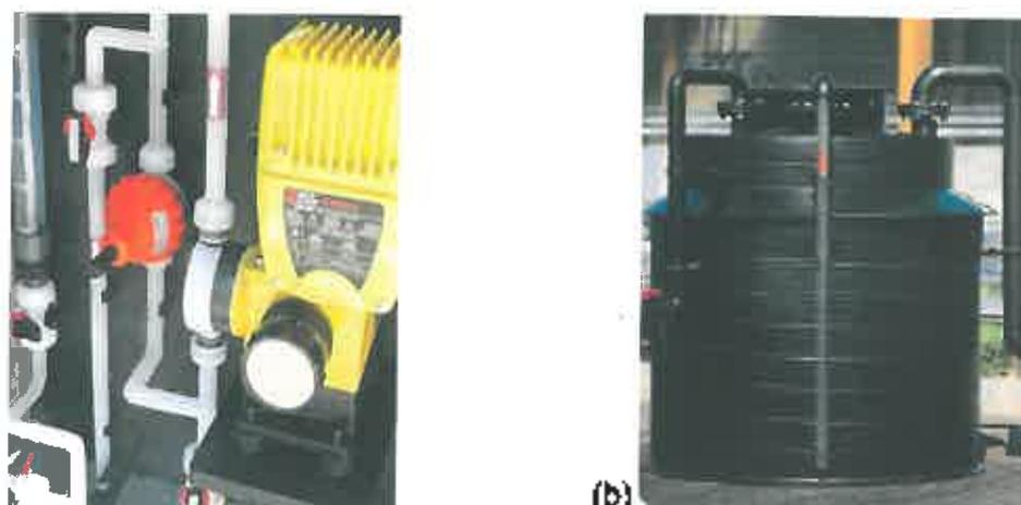
Figure 4. Système d'injection (a) et de stockage (b) du coagulant
