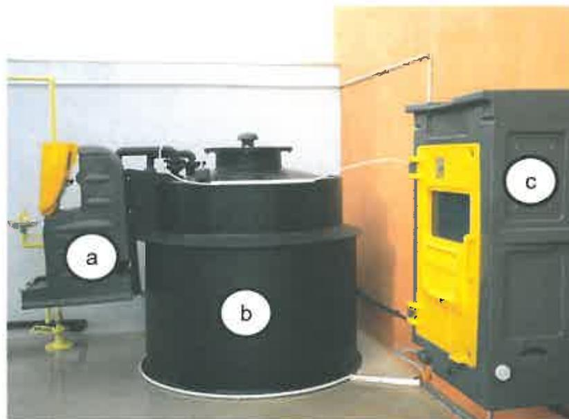
Figure 6. Equipements nécessaires à l'injection de soude : (a) une armoire de dépotage, (b) une cuve de stockage et (c) une armoire de dosage
