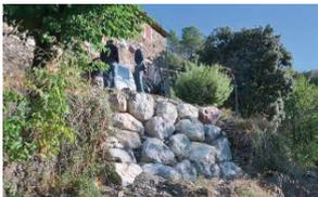
**Le point sur les travaux :** le chemin du Pereyret a nécessité un enrochement de plusieurs mètres de hauteur. Chemin de la Clède, sur 800 m de long, une vingtaine de pins a été abattue afin de restructurer la voirie. Quant au chemin allant du Mas Soubeyran aux Puechs, 500 m de chaussée en mauvais état ont été repris.
