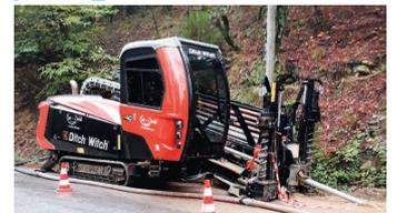
Sur 3,2 km, Enedis a commencé des travaux d'enfouissement d'une ligne haute tension sur la commune afin de fiabiliser le réseau. Les postes sur poteaux seront remplacés par des postes au sol moins vulnérables et qui permettront une réalimentation des usagers plus rapide. Ce chantier prévoit quatre tranches, à partir du hameau des Mouzigniels et jusqu'au lieudit Font Frère.
