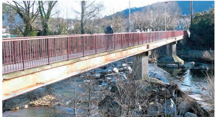
Les piles de la passerelle des Tuileries doivent être consolidées.
