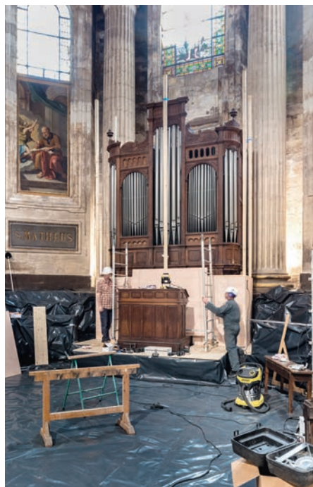
Avant d'installer l'immense échafaudage qui atteindra le sommet de la cathédrale, il faut protéger les ouvrages et mobiliers restés sur place.
