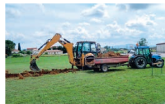
Les pelles mécaniques ont commencé les fondations au mois de mai.
