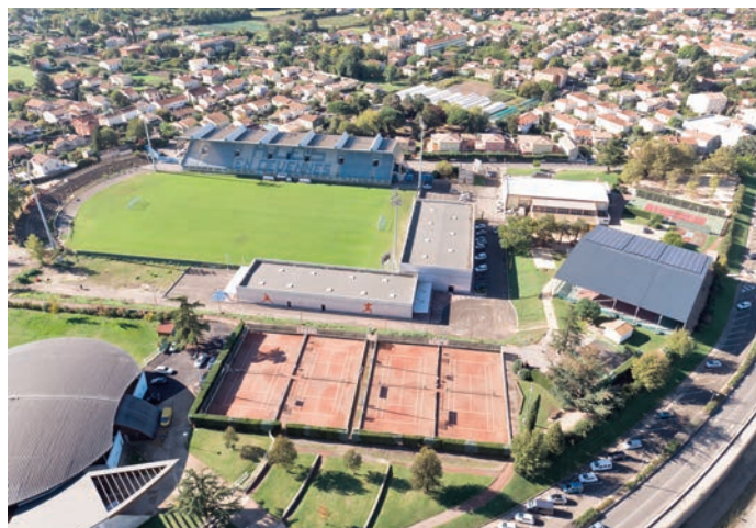
Le complexe sportif de la Prairie permet de dynamiser le quartier, tout en renforçant son image de "poumon vert" d'Alès.
