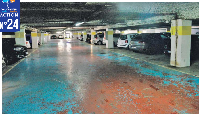
Un tiers du parking du Centre Alès est actuellement en travaux.
