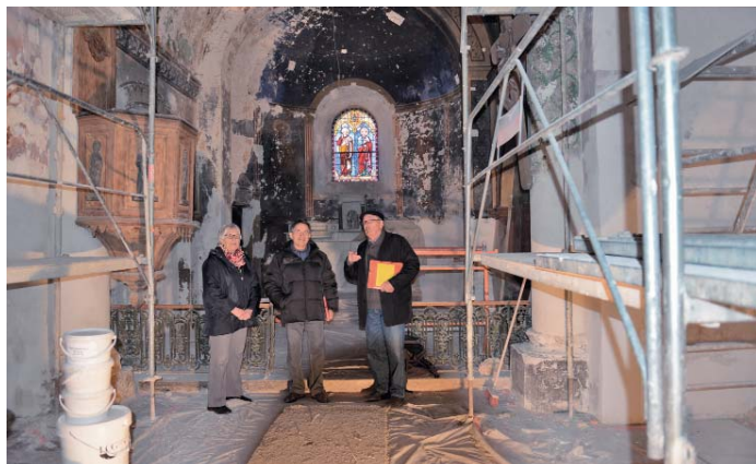
Les représentants de l'association "Les Amis de l'Église", accompagnés du maire de Saint-Paul, s'assurent que le chantier tiennent les délais.
