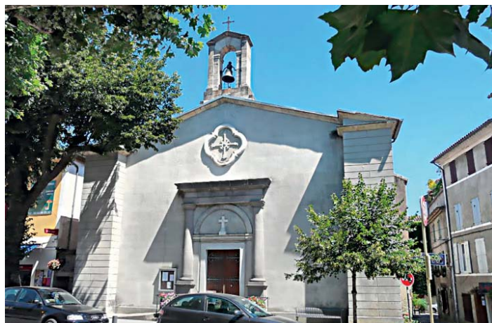
L'église, située face au château, sera restaurée pour la mi-juin.
