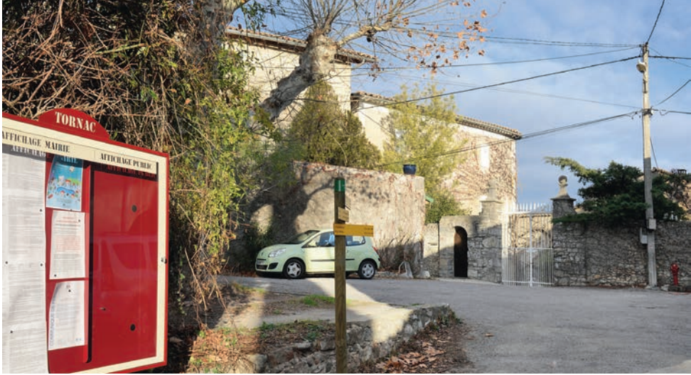
52 lampadaires sont équipés de "ballons fluos" avec des ampoules au mercure. Il faut les remplacer.
