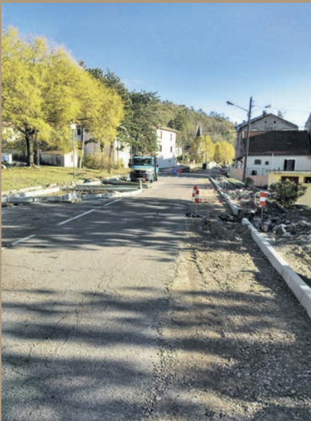
Une vue d'ensemble du chantier.
