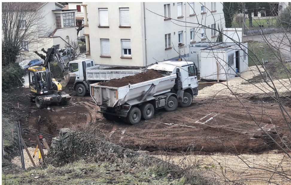
Les travaux du futur bâtiment médical ont démarré mi-décembre.
