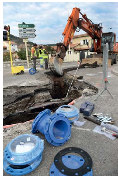
À l'image des travaux sur le quai Bilina, à Alès, le remplacement des canalisations d'eau potable peut perturber la circulation.
