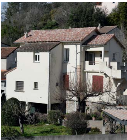
La toiture de la Poste a été rénovée.
