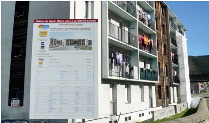
Un bâtiment en rénovation par Habitat du Gard.
