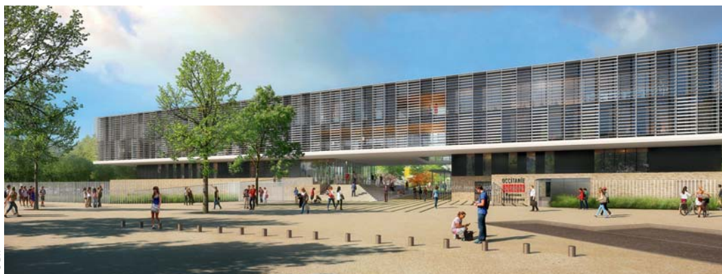
Avec son arche, le nouveau bâtiment d'accueil matérialisera mieux l'entrée et l'image de l'établissement dès la rentrée 2022.
