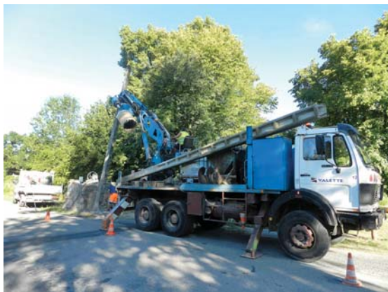
④ L'entreprise Valette a retiré tous les poteaux en béton du réseau ERDF pour les remplacer par de nouveaux candélabres à LED.
