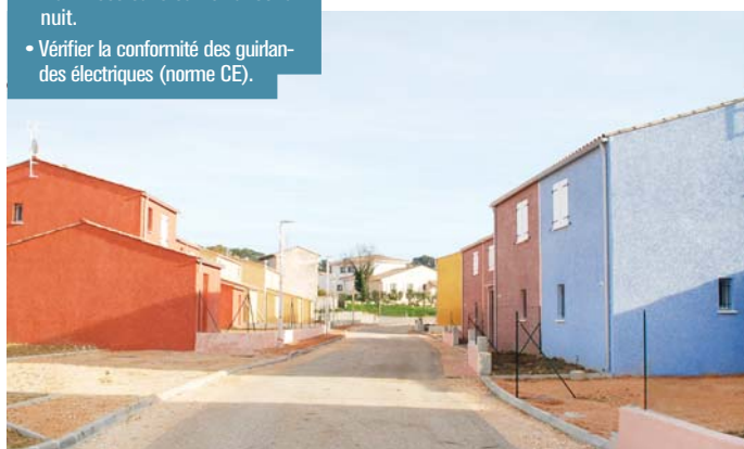
Sur les hauteurs d'Alès, le programme de la résidence "Les Lucioles" affiche de belles prestations pour des habitations tout en couleurs.
