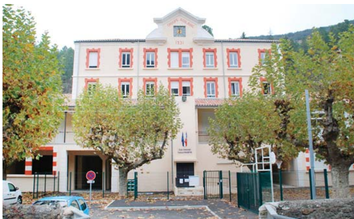
Superbe restauration du bâtiment de l'école de Robiac-Rochessadoules avec quatre appartements type 4 au 1 er étage.
