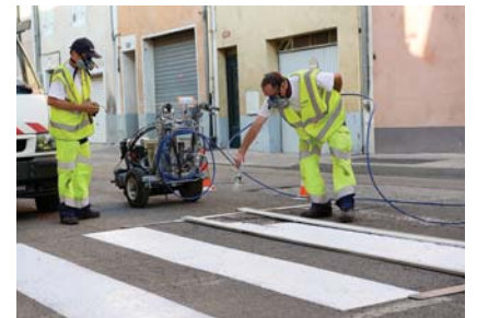
Les services de voirie sont intervenus sur les réparations de chaussée et la signalétique.
