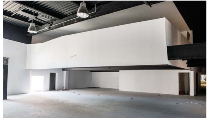
👉 Ici, le hall d'accueil où seront installés les guichets.
