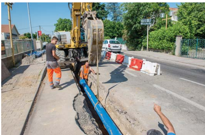
600 mètres de canalisations ont été changés sur la RD 910a.
