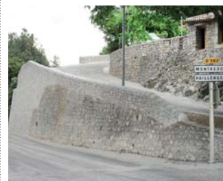
📍 Un mur de 30x8 m de pierres calcaires, pour un budget de 250 000 €, assure la sécurité du hameau de la Croix des Vents.
