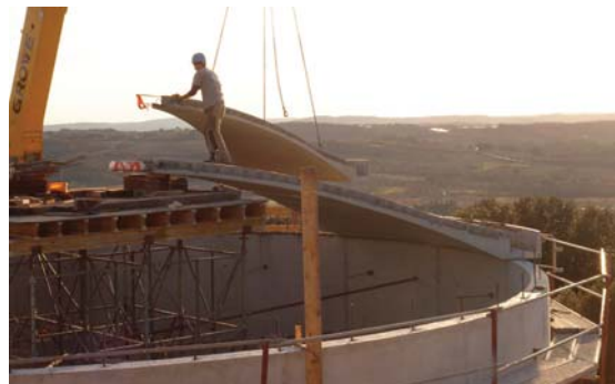
☞ Le nouveau réservoir sur les hauteurs du village réglera les problèmes de capacité mais aussi de pression posés par l'actuelle installation.
