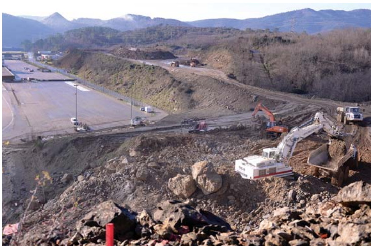
ⓘ 100 000 m 3 de terrassement doivent permettre d'agrandir le tracé.
