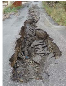
Les fortes pluies n'ont pas épargné la voirie. Dans la nuit du 11 octobre, le Gardon est monté à 5,98 mètres.
