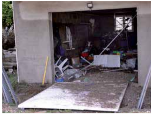
La boue a atteint 2,5 mètres dans de nombreuses maisons.
