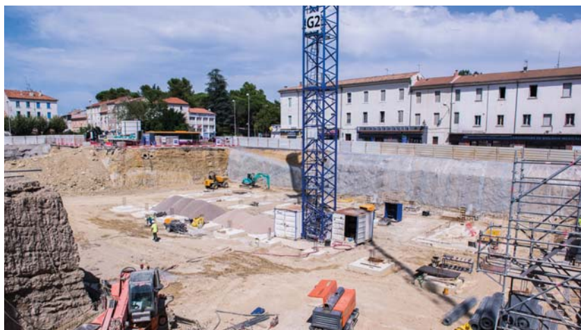
Sur la partie sud du parking, la plus avancée, les fondations sont en place.
