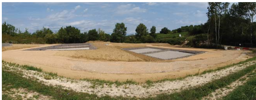
➔ Dans la nouvelle station d'épuration, il ne reste plus qu'à planter les roseaux, filtre naturel écologique.
