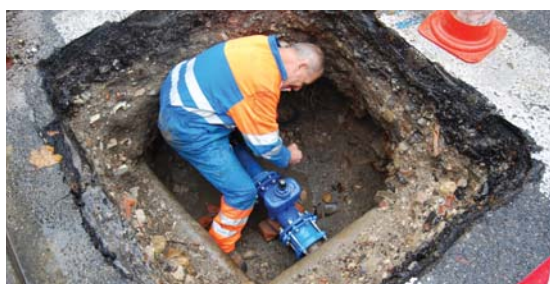
La RéAL profite de la moindre intervention de voirie sur Alès pour changer des tronçons de canalisations poreuses. Une politique qui paye.
