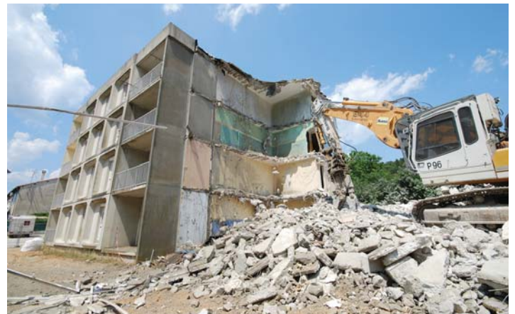
Ce bâtiment contenait de l'amiante et présentait une isolation défectueuse.
