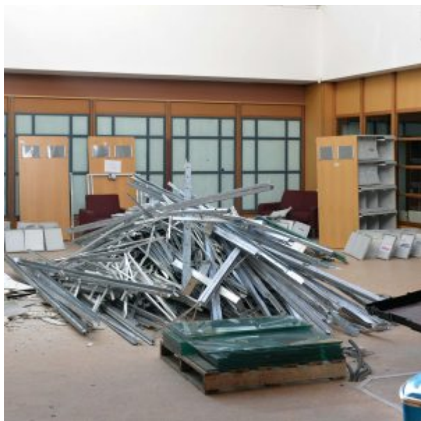
Le projet de modernisation nécessite le démontage complet de la médiathèque et d'une partie de la galerie du Centre Alès.
