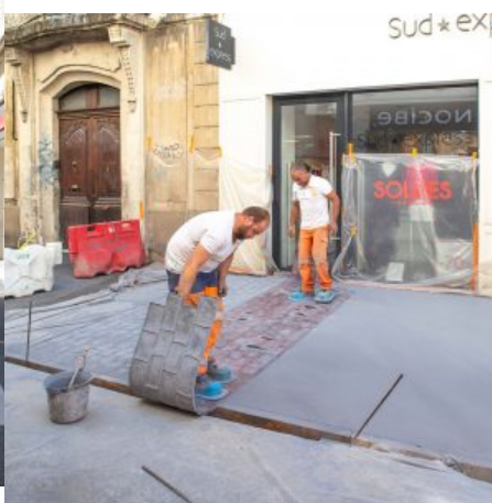
Aménagement du bas de la rue d'Avéjan
