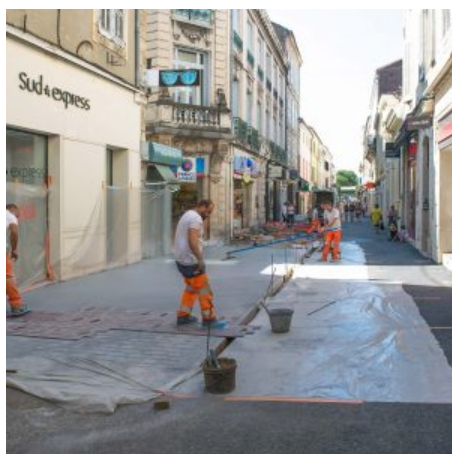
Aménagement du bas de la rue d'Avéjan
