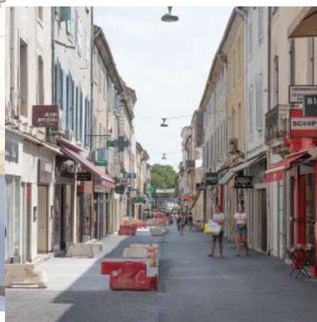
Aménagement du bas de la rue d'Avéjan
