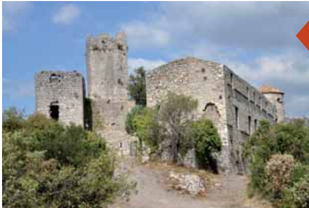
Château de Tornac.
