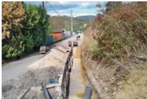
Un renforcement du réseau d'eau potable ainsi que le déplacement de la conduite dans le domaine public ont été engagés au chemin de la Garrigue. Cet effort permet de répondre au besoin en eau pour les nouvelles constructions. Ces travaux sont réalisés par le syndicat Cèze-Auzonnet, avec une participation communale. La commune profite du creusement de la tranchée pour installer un réseau d'eau pluvial qui sera fort utile lors de gros orages.
