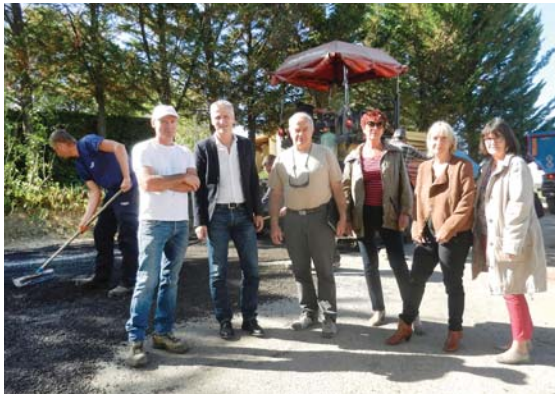
🕒 Les conseillers départementaux Philippe Ribot et Valérie Meunier en visite sur le chantier aux côtés des membres du conseil municipal.
