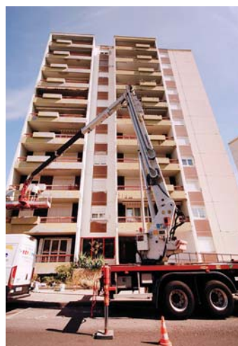
③ Après le nettoyage des façades, la reprise des bétons abîmés puis une remise en peinture donneront un nouvel éclat au bâtiment.
