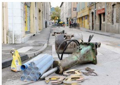
➤ La réfection de l'ancienne conduite d'eau potable (rue Pasteur et place du général Leclerc) est désormais terminée. Une nouvelle canalisation haute pression est en place, ainsi qu'un nouveau tapis routier.
