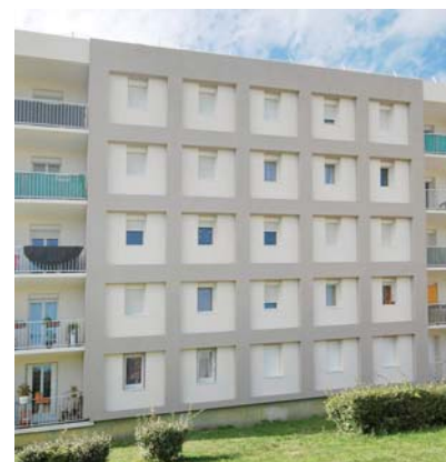
② Les Aubépines ont bénéficié d'un programme de réfection de la toiture et d'isolation thermique des façades, ainsi que de la pose de radiateurs rayonnants.
