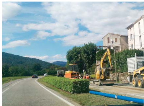
Avenue La Bastide, les nouvelles conduites d'eau haute pression sont en cours d'installation.
