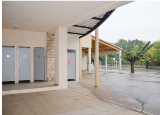
Les sanitaires ont été entièrement refaits, complétés d'un WC handicapés.
