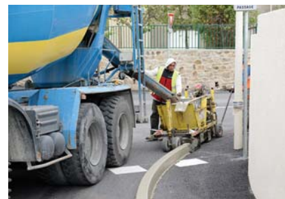
➤ Le pose-bordures était à l'œuvre le 6 novembre, au quartier Dourtoulan, pour la dernière touche de sécurisation du nouveau giratoire aménagé à l'angle de l'ancien chemin de Méjannes et du chemin sous Saint-Étienne.
