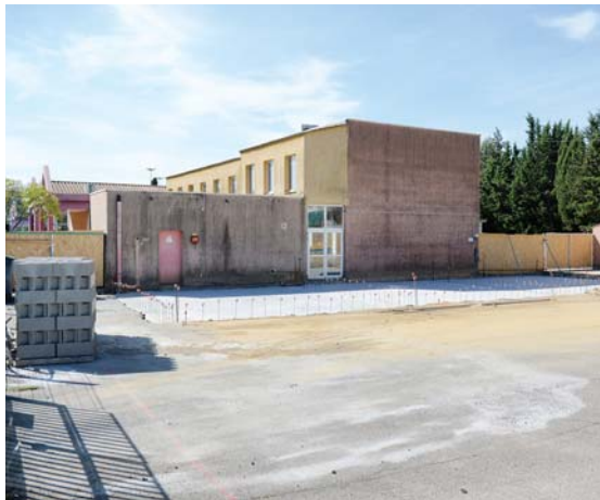
La construction de trois salles de classe a débuté cet été à Claire-Lacombe.
