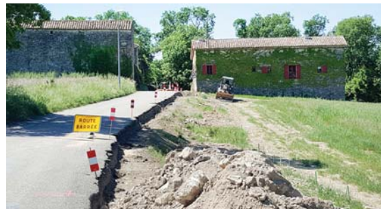
Une première tranche de travaux a été lancée à l'entrée ouest du village.
