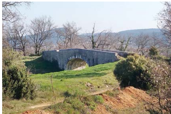
☞ La Passerelle, un site remarquable qui attend patiemment sa renaissance.
