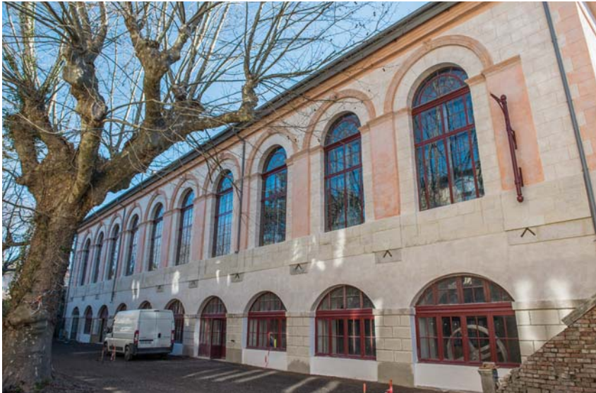
④ La façade principale de Maison Rouge a revêtu son aspect définitif avec une peinture à la chaux et des teintes chaudes sur les modénatures, pilastres et chemins d'angle. Ce rendu choisi par les Monuments historiques est fidèle à celui de la fin du XIX e siècle, date des derniers ravalements.
