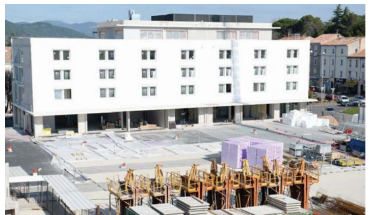
④ Les façades de l'hôtel sont en cours de finition. Les entreprises ont attaqué l'aménagement intérieur des parties communes et des 72 chambres pour une livraison prévue courant juin.
