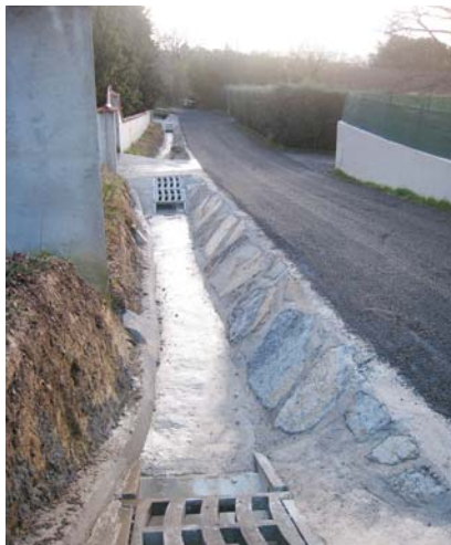
➋ Après une semaine de travaux, la rue affiche un nouveau visage.
