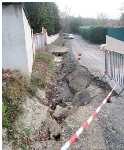
➊ Après les pluies, le spectacle désolant de la voirie.
