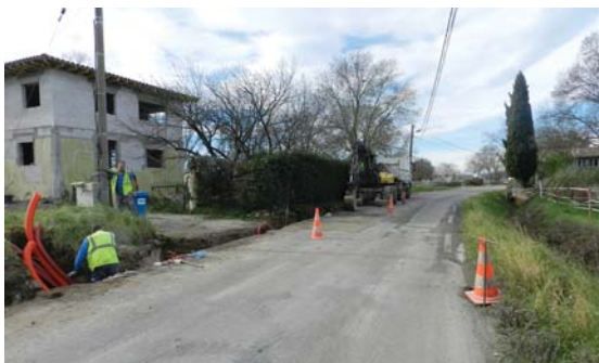
Le chantier de la route de Cardet permettra de réduire la pollution visuelle créée par les câbles électriques et de téléphone.
