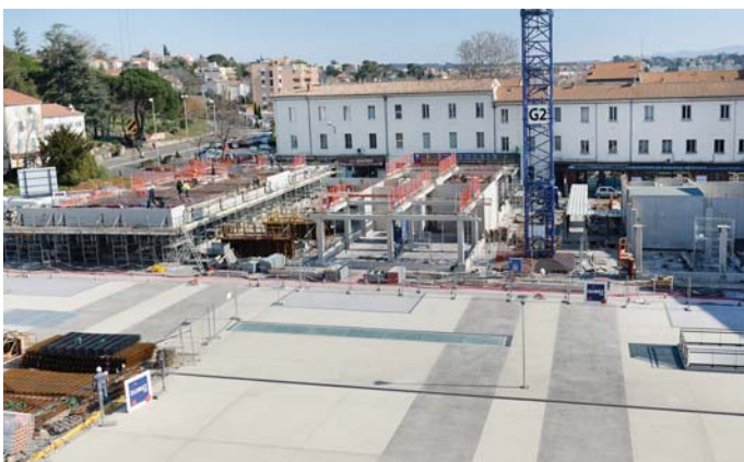
④ Les trois résidences qui compteront 45 appartements et 7 commerces en rez-de-chaussée sont en train de s'élever à grande vitesse. La livraison des logements s'échelonnera de fin 2016 à début 2017.
