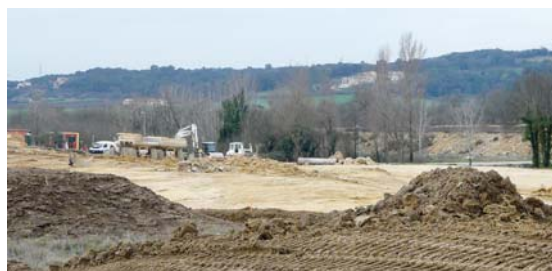
Sur la zone Synerpôles, les engins de chantier sont à pied d'œuvre pour accueillir de nouvelles entreprises sur la commune.
