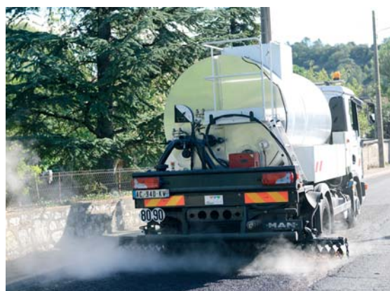
Plusieurs rues du quartier ont été regoudronnées durant l'opération.
