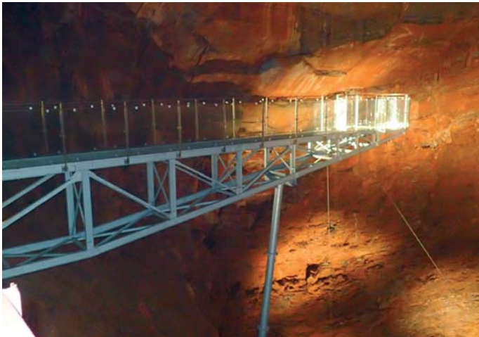
La maîtrise de la ferronnerie d'art et de la charpente métallique est visible sur cette construction hors normes.
