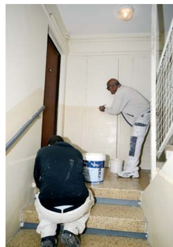
Les chantiers ont débuté pour cette rentrée 2015 dans les halls et cages d'escaliers.
