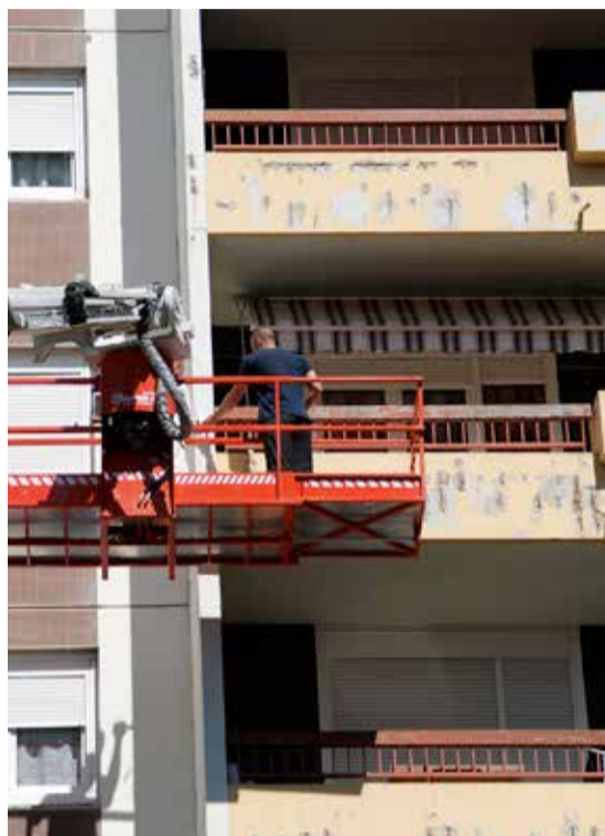
Les travaux de reprise des bétons ont débuté à la tour 1B Grand rue Jean Moulin le 18 mai. Ils dureront 3 mois.
