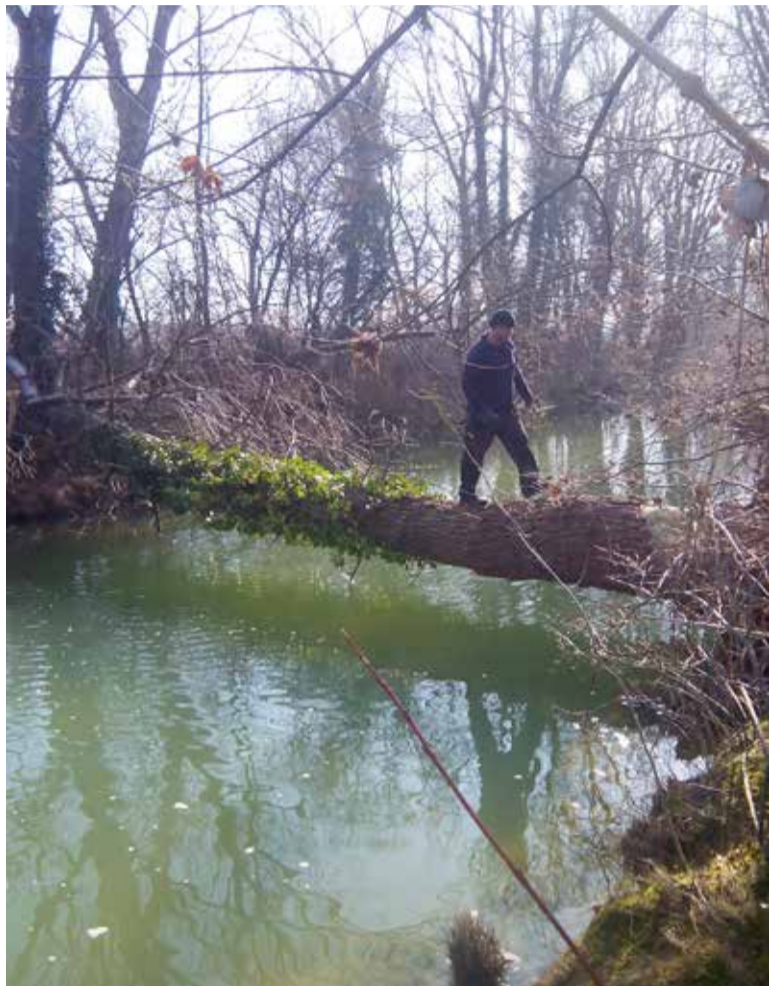
⤴ Nommés embâcles, ces obstacles favorisent les inondations lors des fortes pluies.
