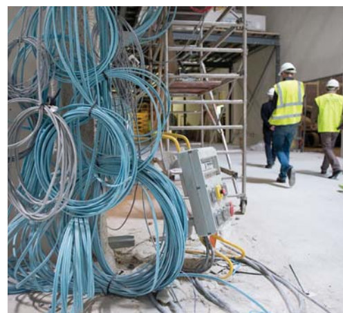
④ Des milliers de kilomètres de câbles sont tirés.
