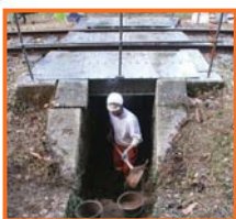
56 ouvrages hydrauliques traversant la voie ont été remis en état manuellement dans les accès difficiles.
