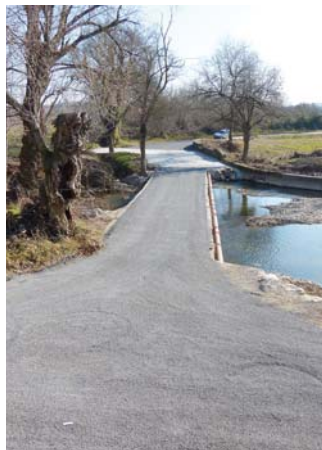
Le Pont de Tribies est désormais réhabilité.
