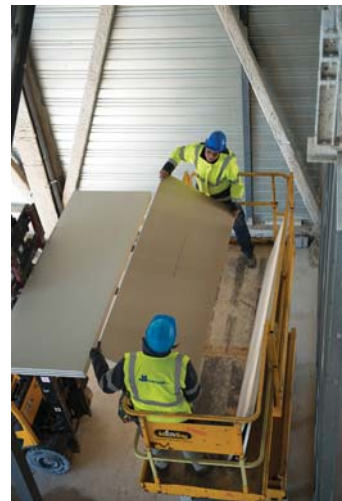
Ⓜ Une quarantaine d'ouvriers travaille actuellement sur le chantier.
