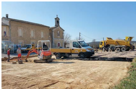
➔ Suite au parking, un grand espace public convivial sera bientôt aménagé.
