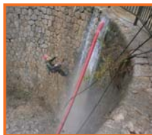
Les travaux de purge de pierres instables en paroi ont nécessité des interventions acrobatiques. Grillages ou filets ont été posés.
