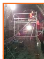
Opération de rejointement dans les tunnels.
