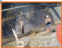
Les abords de la voie et des ouvrages ont été dévégétalisés sur 13,2 km.
