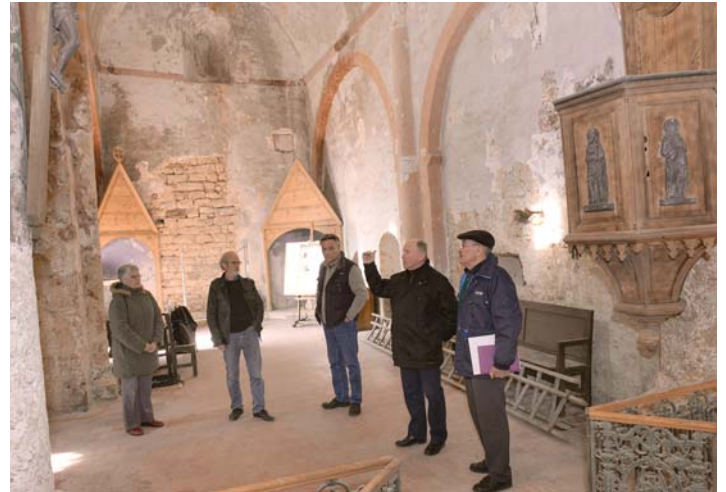
Visite du chantier par les principaux acteurs de la restauration.
