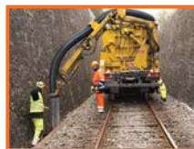
Une aspiratrice a évacué pierres, terre et végétaux accumulés dans les fossés maçonnés.
