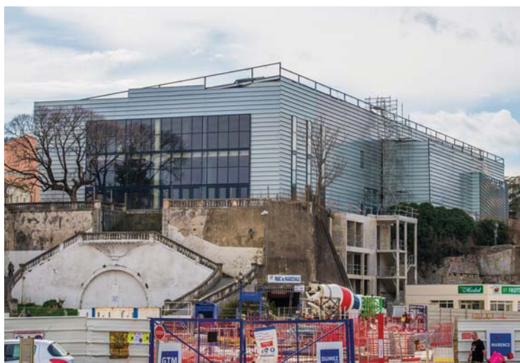
Ⓜ Le bardage visible depuis le mois de février-mars n'est qu'une "première peau". La façade définitive sera posée courant avril.
