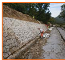
Les maçonneries ont été entièrement reprises, renforcées et rejointées. Les 7,4 km de murs de soutènement ont été confortés.
