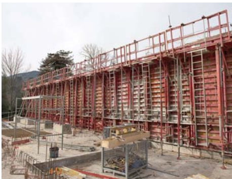
ⓘ D'impressionnants coffrages de béton sont nécessaires pour réaliser l'extension de 1 612 m 2 .
