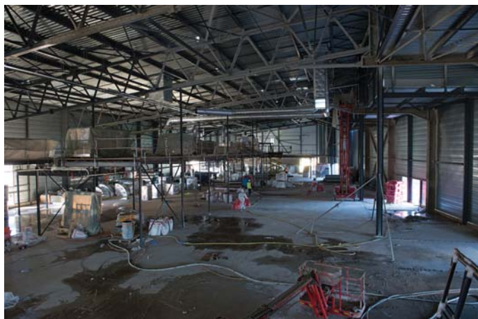
④ Le volume intérieur est impressionnant pour ce bâtiment qui accueillera d'ici cet été 8 salles de cinéma et 1 200 fauteuils.
