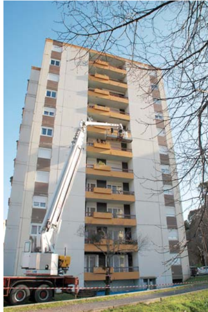
L'Office s'engage à améliorer le quotidien des locataires tout en optimisant la performance du bâti.
