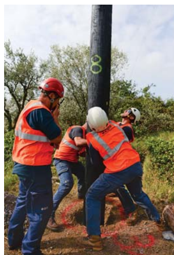
« Au plus près de ses communes membres, le SMEG coordonne les travaux d'amélioration des réseaux électriques avec ERDF. »
