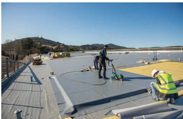
④ En toiture, les entreprises ont attaqué l'étanchéité en février. Le bâtiment est désormais hors d'eau et hors d'air.
