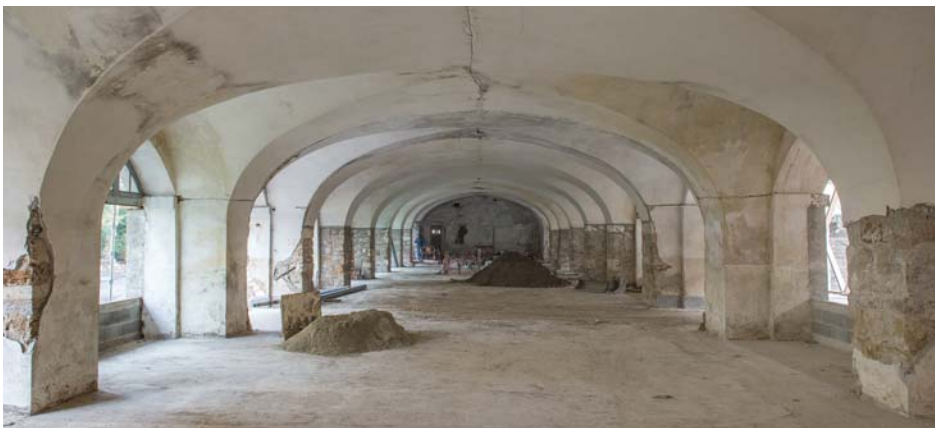
ⓘ Le bâtiment Maison Rouge est classé à l'inventaire supplémentaire des Monuments historiques. Les travaux consistent à réhabiliter ses 1 714 m 2 en conservant le maximum d'éléments.
