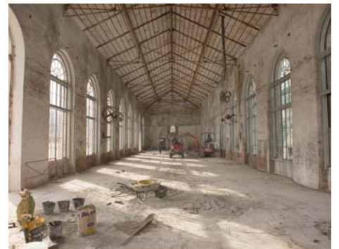
ⓘ La "Grande Rouge", c'est cette magnifique salle, au 1 er étage de l'ancienne filature, éclairée par vingt baies cintrées, où des Cévenoles ont tissé la soie jusqu'en 1965. Une nouvelle dalle est en train d'être coulée.
