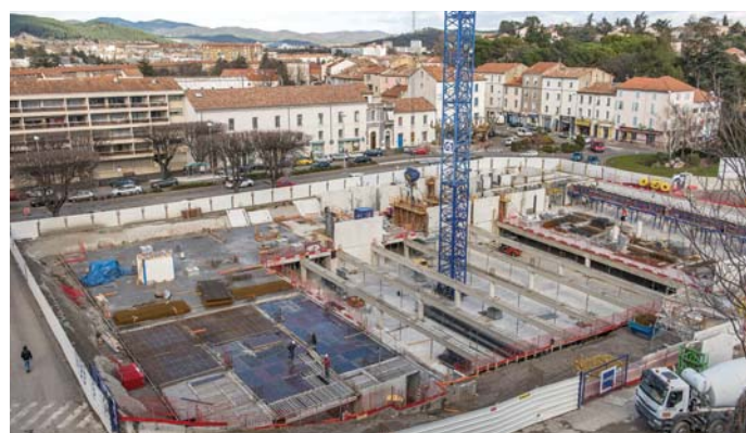
④ Les entreprises se focalisent sur la partie nord (côté quai Boissier-de-Sauvages) pour terminer la construction du niveau -1 du parking. Le niveau -2 est achevé.
