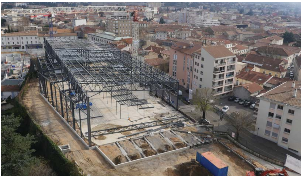
1 400 tonnes de poutres métalliques ont permis de créer l'ossature du multiplaxe, dont l'ouverture est prévue pour cet été.
