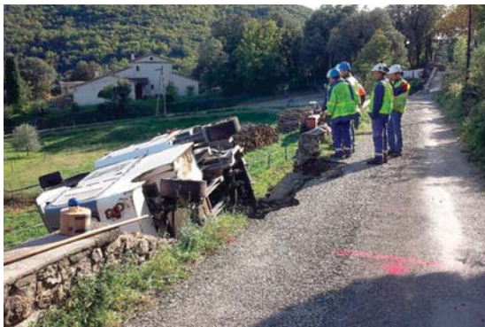
Effondrement d'un mur de soutènement au chemin du Temple.
