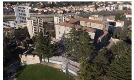
Les six bastions, les trois échauguettes, ainsi que le pont d'accès ont été inscrits à l'inventaire des Monuments historiques le 24 mai 1973. En tout, le Fort compte 350 mètres de fortifications composées de 90 postes de tir pour les pièces d'artillerie et les fantassins.
