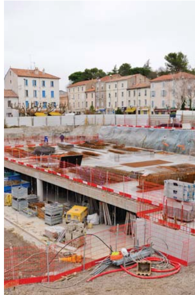
1 8100 m 3 de béton et 600 tonnes d'acier sont nécessaires pour créer les deux niveaux de stationnement.
