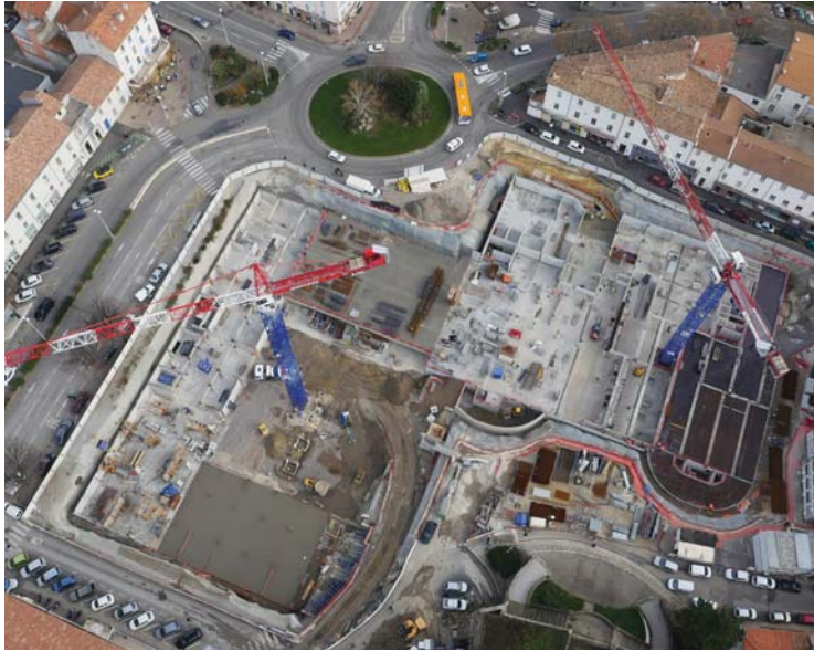
1 La partie sud de la place (à droite) est la plus avancée : les deux niveaux souterrains sont terminés et seront recouverts d'une dalle en janvier. La partie nord (à gauche) est achevée à 40 %.
