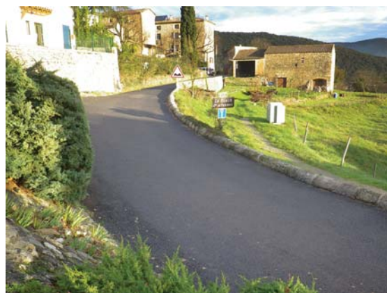
Le Puech, nouveau goudron et réseaux enterrés.
