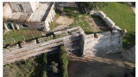
Éléments de fortification classique en forme de pointes, les bastions permettaient de défendre les angles. Le Fort Vauban en compte six, qui sont reliés entre eux par des courtines (remparts).
