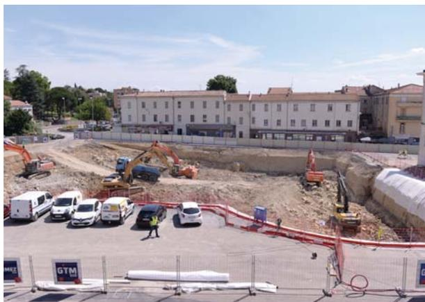
Les pelles sont à l'œuvre pour décaisser la place des Martyrs-de-la-Résistance sur sept mètres de profondeur.
