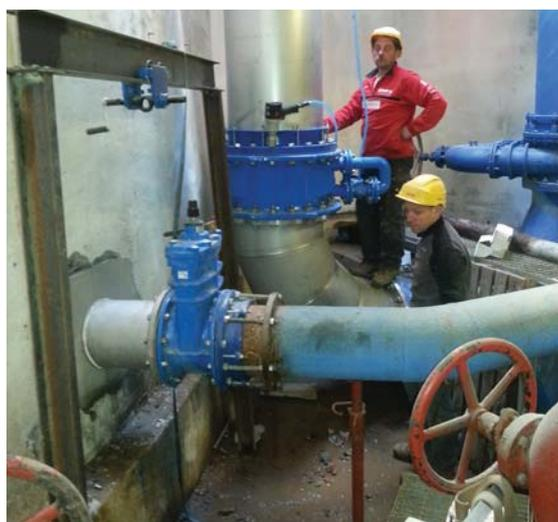
Toutes les conduites en acier, aujourd'hui poreuses, sont remplacées par des conduites en acier inoxydable à la durée de vie largement supérieure.
