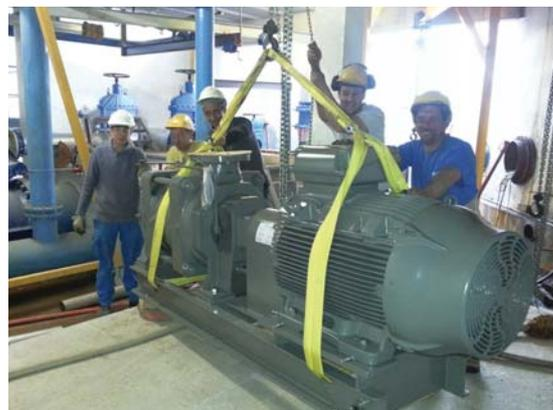
Ici, l'installation d'une des deux nouvelles pompes surpuissantes (2,6 tonnes).
